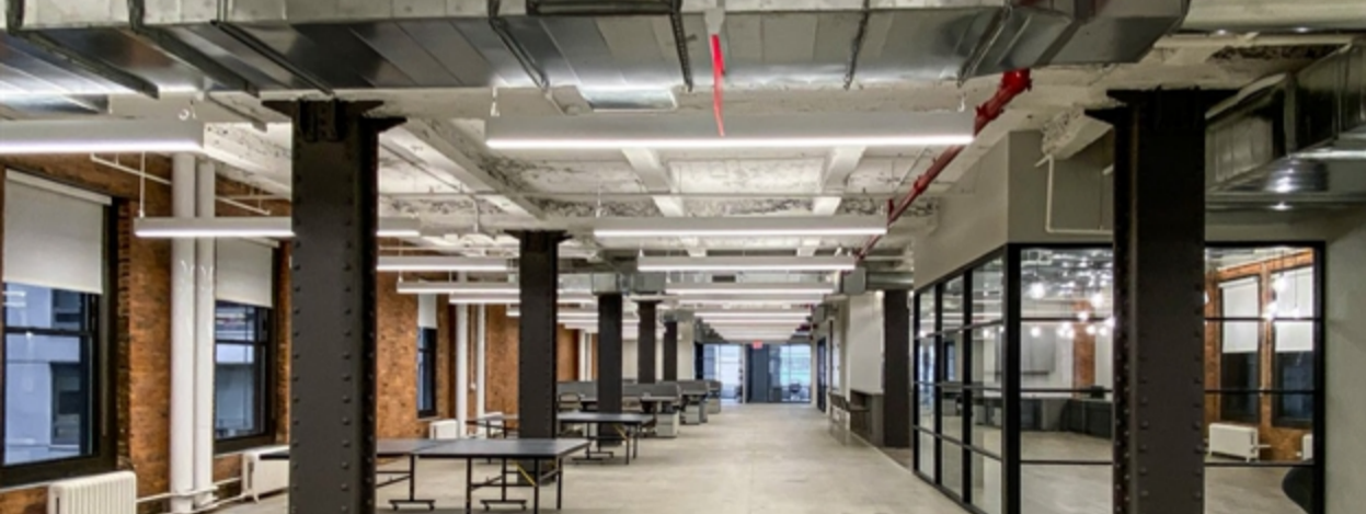
ACTUAL PHOTOS OF 15 TH FLOOR
