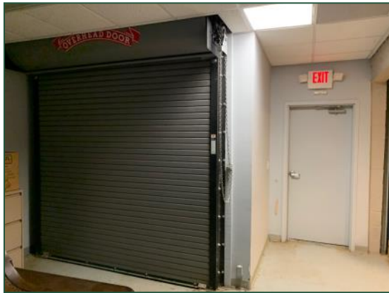
Front Door & 10' x 10' Dock Door
